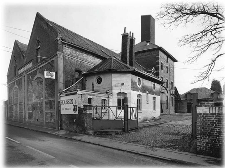
Descriptif : Atelier de fabrication (ancienne usine de boutons d'or) en rez-de-chaussée avec toit à longs pans en ciment amiante et tuile flamande mécanique ; atelier de fabrication (brasserie) avec toit en pavillon ; magasin industriel en rez-de-chaussée surélevé avec monte-charge en bois ; écurie en rez de chaussée ; conciergerie avec sous-sol, percé d'oculi.
